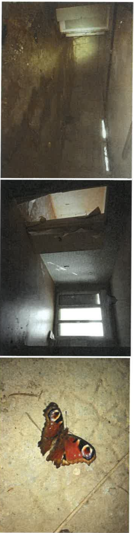
Inspection du sous-sol ainsi que des étages et cadavre de Paon-du-jour
